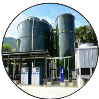
Plante de tratamiento de lixiviados
