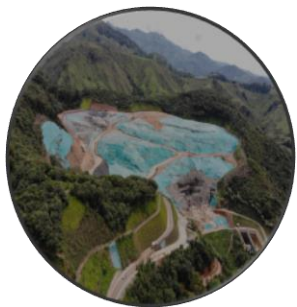
Adecuaciones Vaso Altaír y obras complementarias
